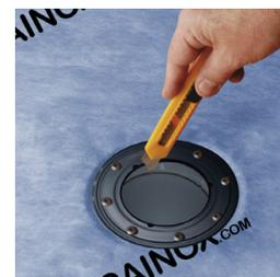
**5** Corte el cuerpo tubular de PVC según sus necesidades. Para ello, ha de tener el cuenta el grosor de la capa de cemento cola y el del acabado final (gres, gresite, porcelánico, etc). La máxima altura que podrá cortar es dejando dos anillas (véase el dibujo)
