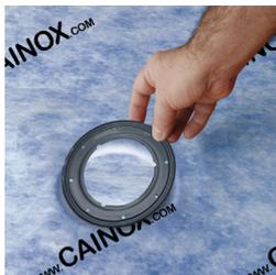
**4** Coloque los tornillos, una vez fijados recorte la tela sobrante del centro de la cazoleta.
