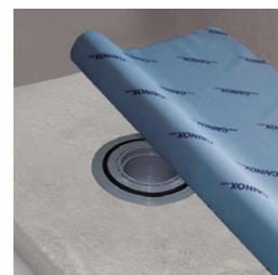
**3** Pince la tela impermeabilizante a la cazoleta mediante la brida (la brida de polipropileno tiene 3 puntos que encajan con 3 pivotes de la cazoleta y sólo hay una posición en la que los agujeros de los tornillos de la brida encajan perfectamente con los de la cazoleta). Es preferible que antes de la instalación lo compruebe y lo marque para no tener dificultad una vez lo esté instalando. La parte lisa de la brida es la que va debajo (presionando la tela).
